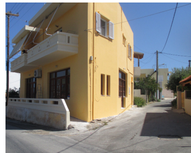
②_Achtung: Rechts abbiegen
